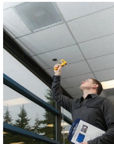
Comprobación de la temperatura de descarga en conductos de distribución de aire.
