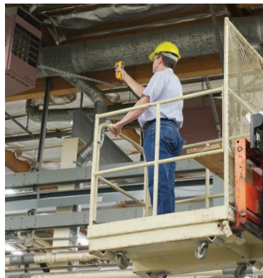
Medida de la temperatura en equipos instalados en el techo.
