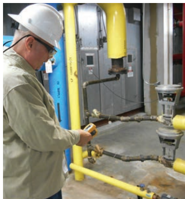
Comprobación del purgador para verificar si se ha averiado, se ha abierto y pierde vapor.
